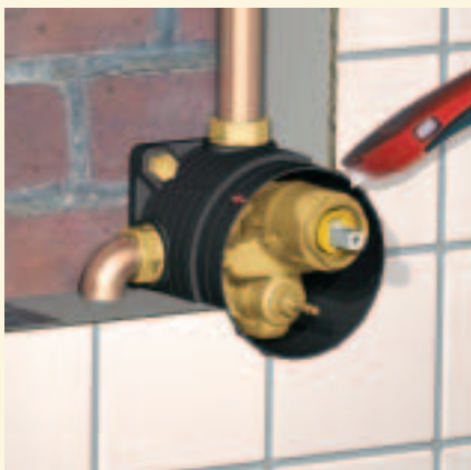
4. Skrátiť plášť z elastomeru nožnicami alebo nožom.
