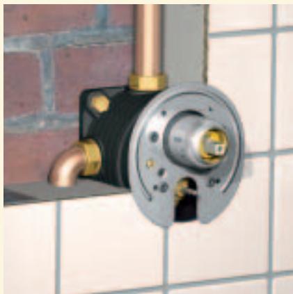
5. Montáž puzdra. Upevnenie ružíc a preradovača.
